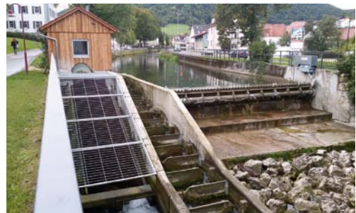
Abb. 4: Perfekt gelöst: Wegen der begrenzten Platzverhältnisse wurden an der Fils die Wasserkraftschnecke, der Fischpass und die Wehrklappe parallel nebeneinander angeordnet. Foto: Martin Frey
