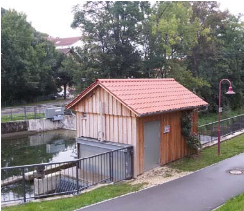
Abb. 6: Ein Fußweg führt direkt an der Wasserkraftanlage in Deggingen vorbei. Foto: Martin Frey
