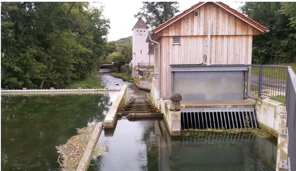
Abb. 5: Die Anlage vom Oberlauf aus gesehen: rechts das Betriebsgebäude mit dem Rechen und dem Schieber, in der Mitte der Fischpass und links die Wehrklappe. Foto: Martin Frey
